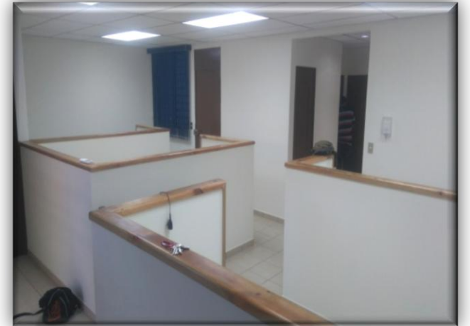
Construcción Salas de Audiencias Juzgado de Paz San José Villanueva
